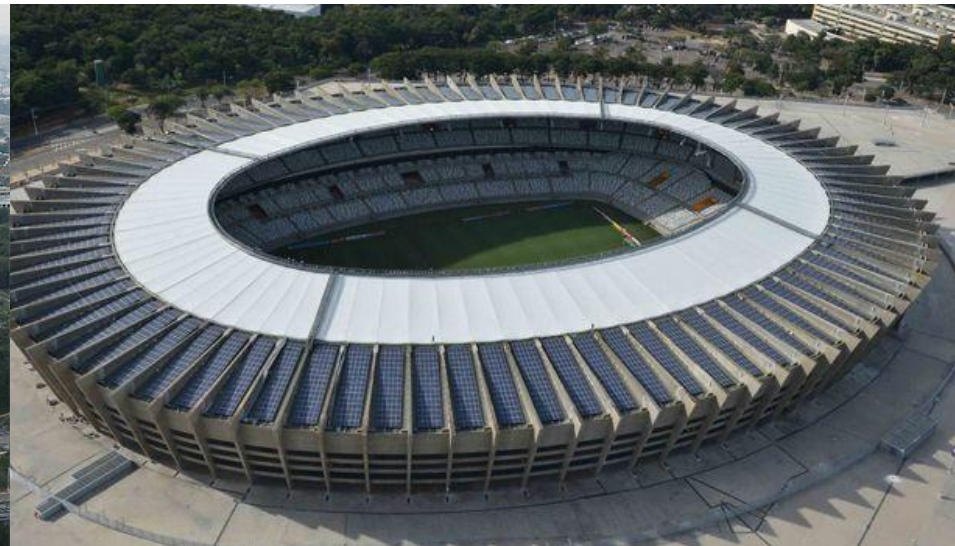
Estádio de energia solar fotovoltaica - Mineirão
